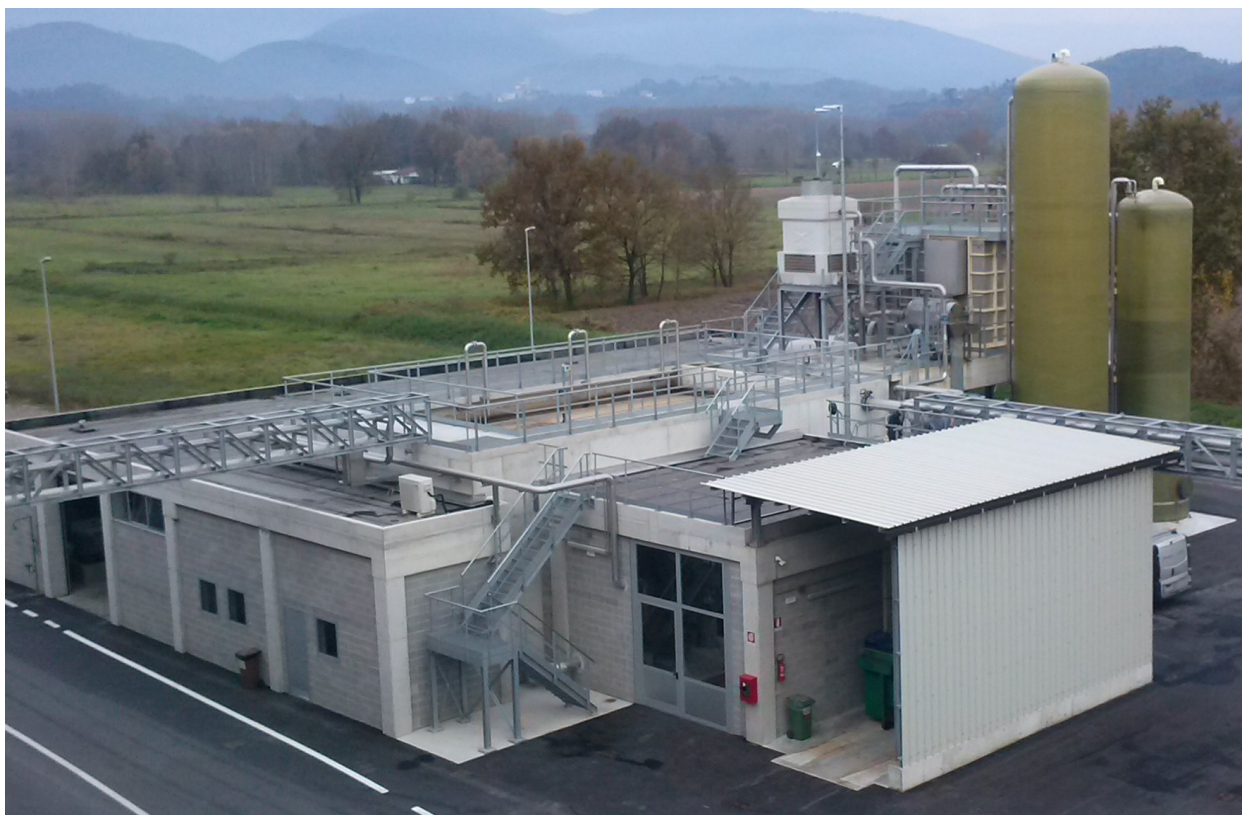
Fig. 10 Impianto water reuse
