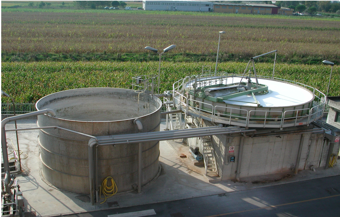
Fig. 9 Flottatore ad aria disciolta della linea PM3
