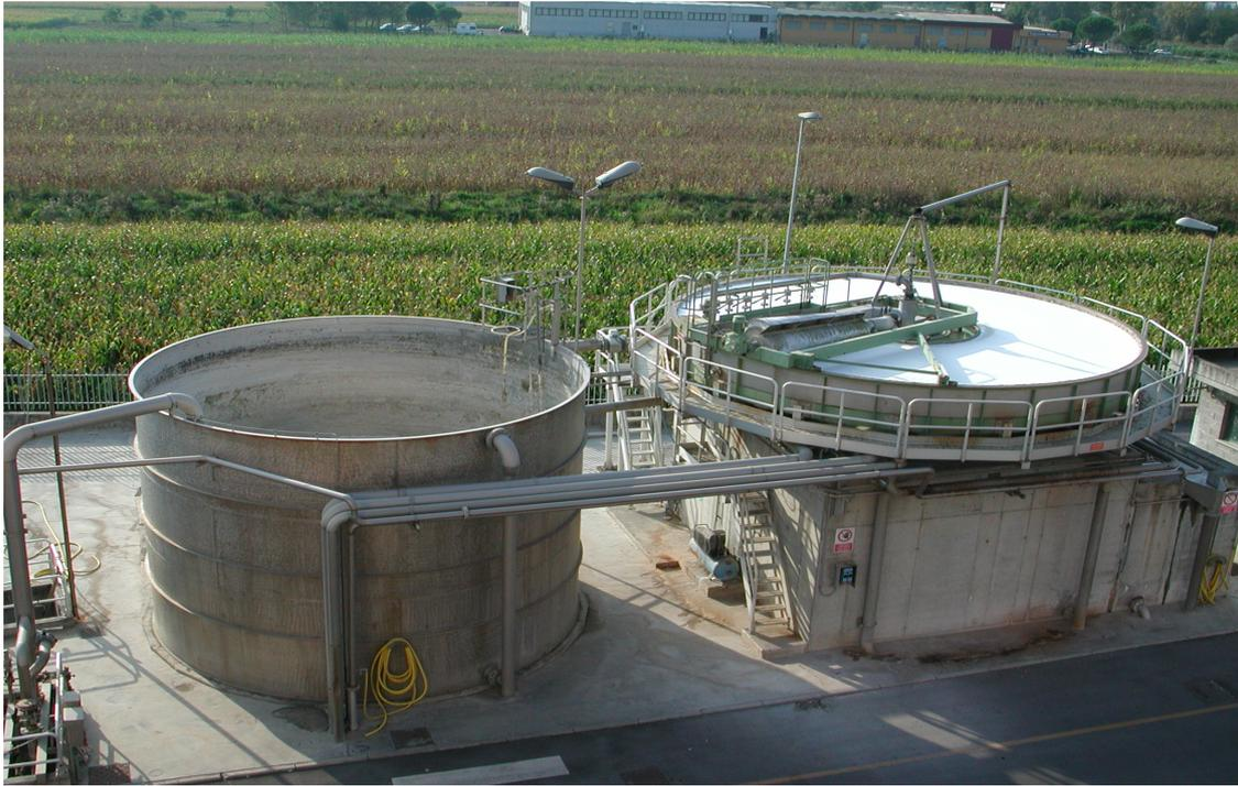
**Fig. 9 Flottatore ad aria disciolta della linea PM3**
