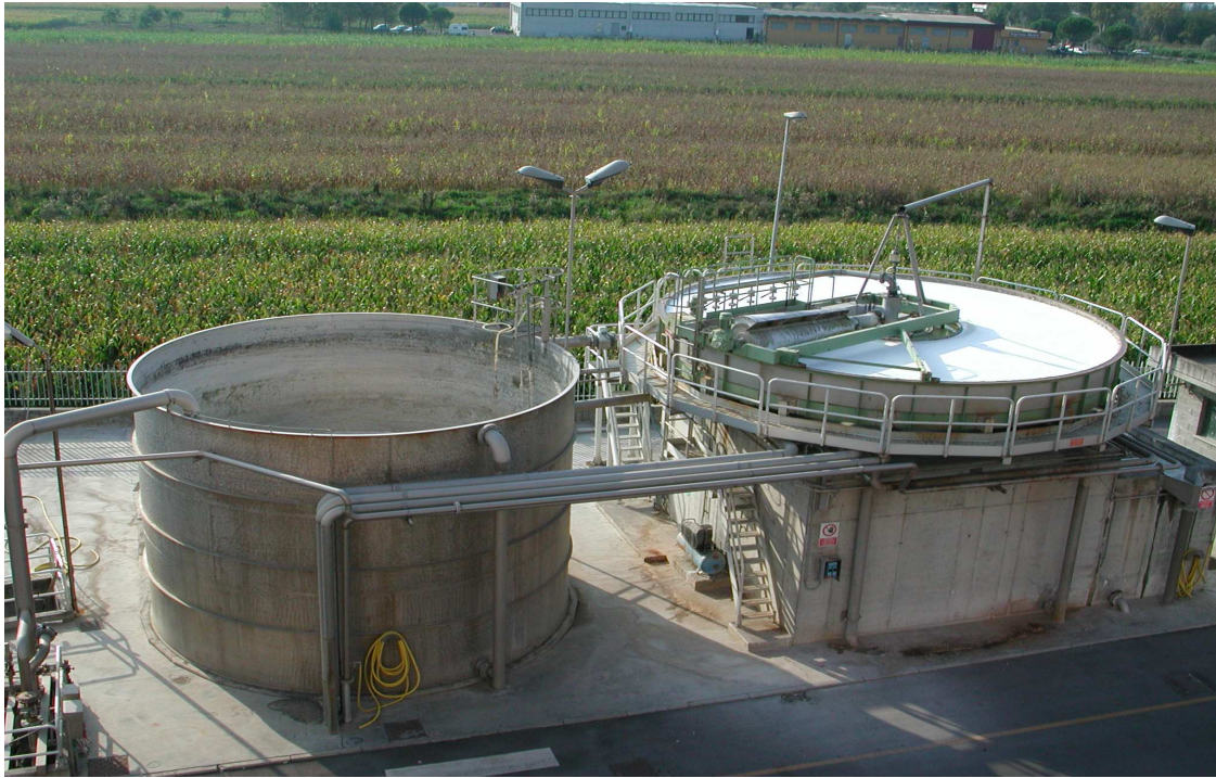
Fig. 9 Flottatore ad aria disciolta della linea PM3
