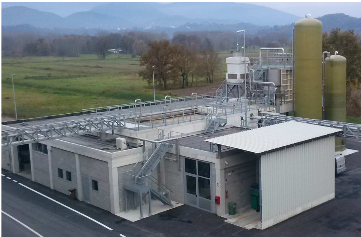
Fig. 10 Impianto water re-use
